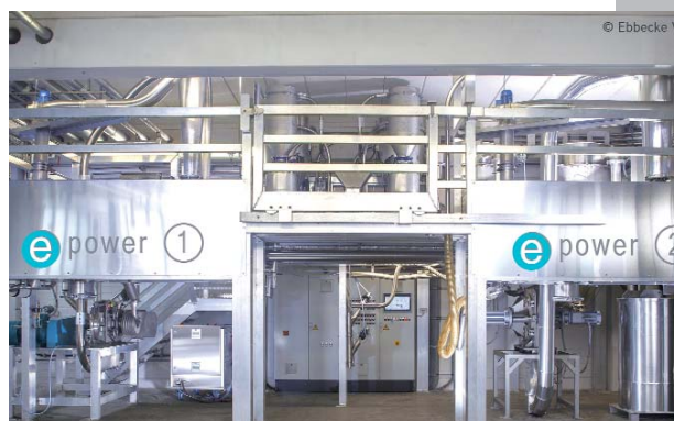
Kryogene-Vermahlungs-Anlage; Kaltmahlung von Kunststoffen und anderen elastischen Materialien sowie temperaturempfindlichen Produkten.
